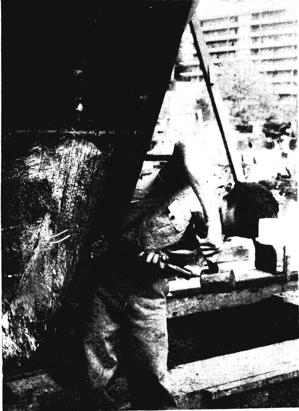
Tapando una vía de agua
